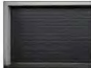
EXISTING ROLLER GARAGE DOOR - MONUMENT
