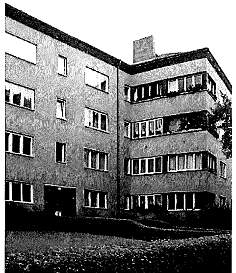
Figure 3.26 Hohenzollerndamm, Berlin, 1925-26 Source: http://www.luise-berlin.de/abbild/lexikon/chawi/w/wohnanlage_auguste_viktoria_strasse_411062.htm
